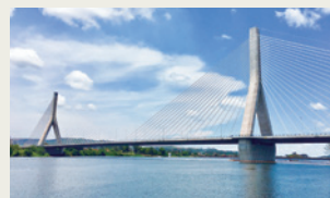
ウガンダ共和国・ナイル川源流橋
